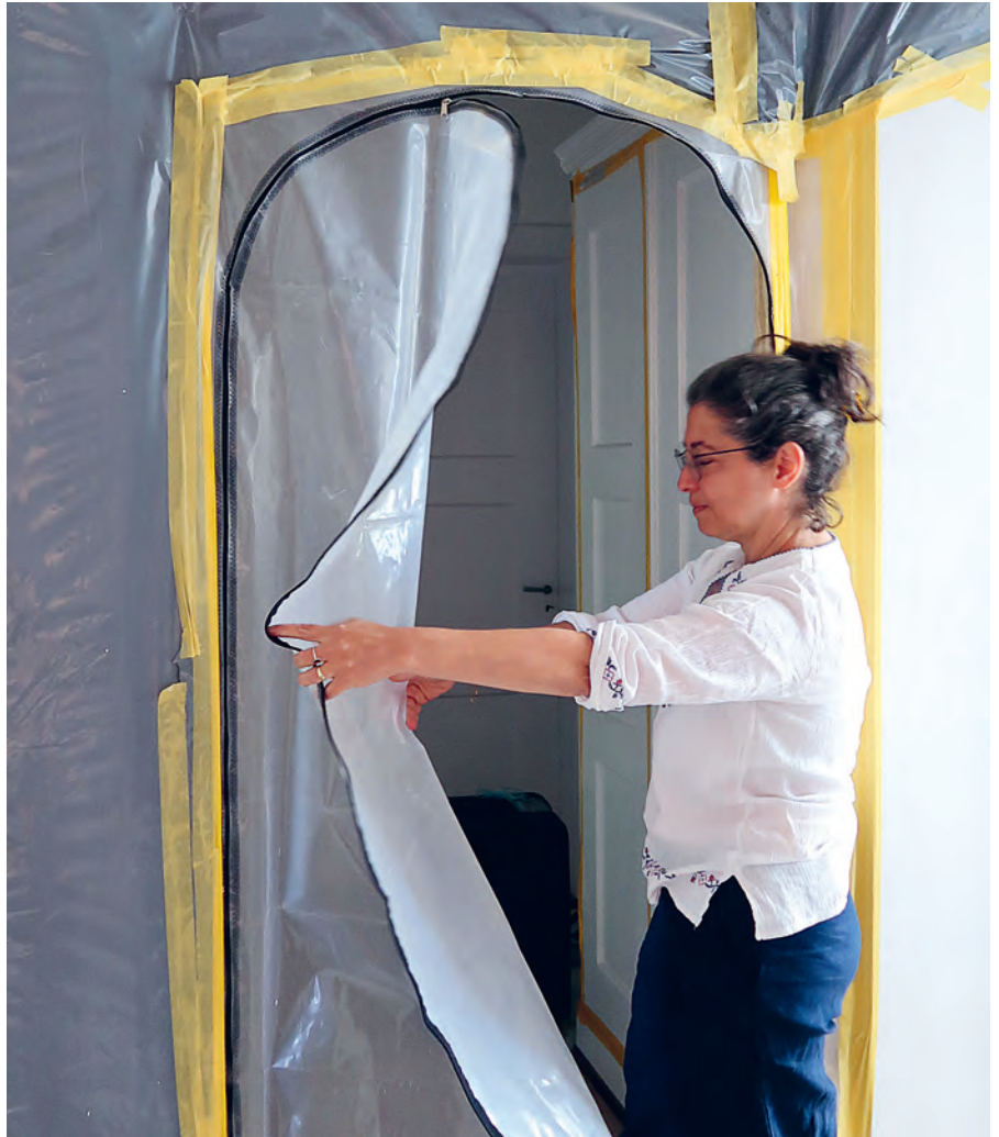
Lale Sala demonstriert, wie sie durch die fragile Staubschutztür zu den dahinterliegenden Wohnräumen gelangt. Das System erinnert an einen Mottenschrank.
