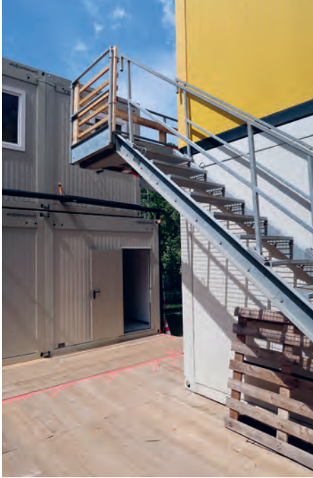
Mini Container-Siedlung: Darin befinden sich eine Küche sowie mehrere Nasszellen.
