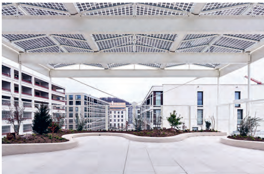
Nebst dem Sportplatz gibt's auf dem Dach einen Aufenthaltsbereich, das sogenannte Waldzimmer. Die Pflanzenwahl orientiert sich an der Vegetation des Sihltals.
