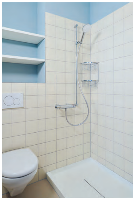
In den grossen Familienwohnungen wurde ein zusätzliches Badzimmer mit WC und Dusche eingebaut. Die Duschrinnen verfügen über ein System zur Wärmerückgewinnung.
