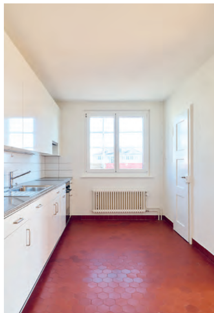
Dank dem minimalen Eingriff in den Küchen konnten die Klinkerböden erhalten werden. Auch die hochwertigen Metallküchen sind weiterhin im Einsatz. Sie wurden aufgefrischt indem beispielsweise die Türen der Unterschränke ersetzt wurden.
