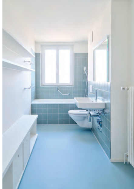
Die bestehenden Badzimmer wurden komplett erneuert und sämtliche Sanitärleitungen ersetzt.
